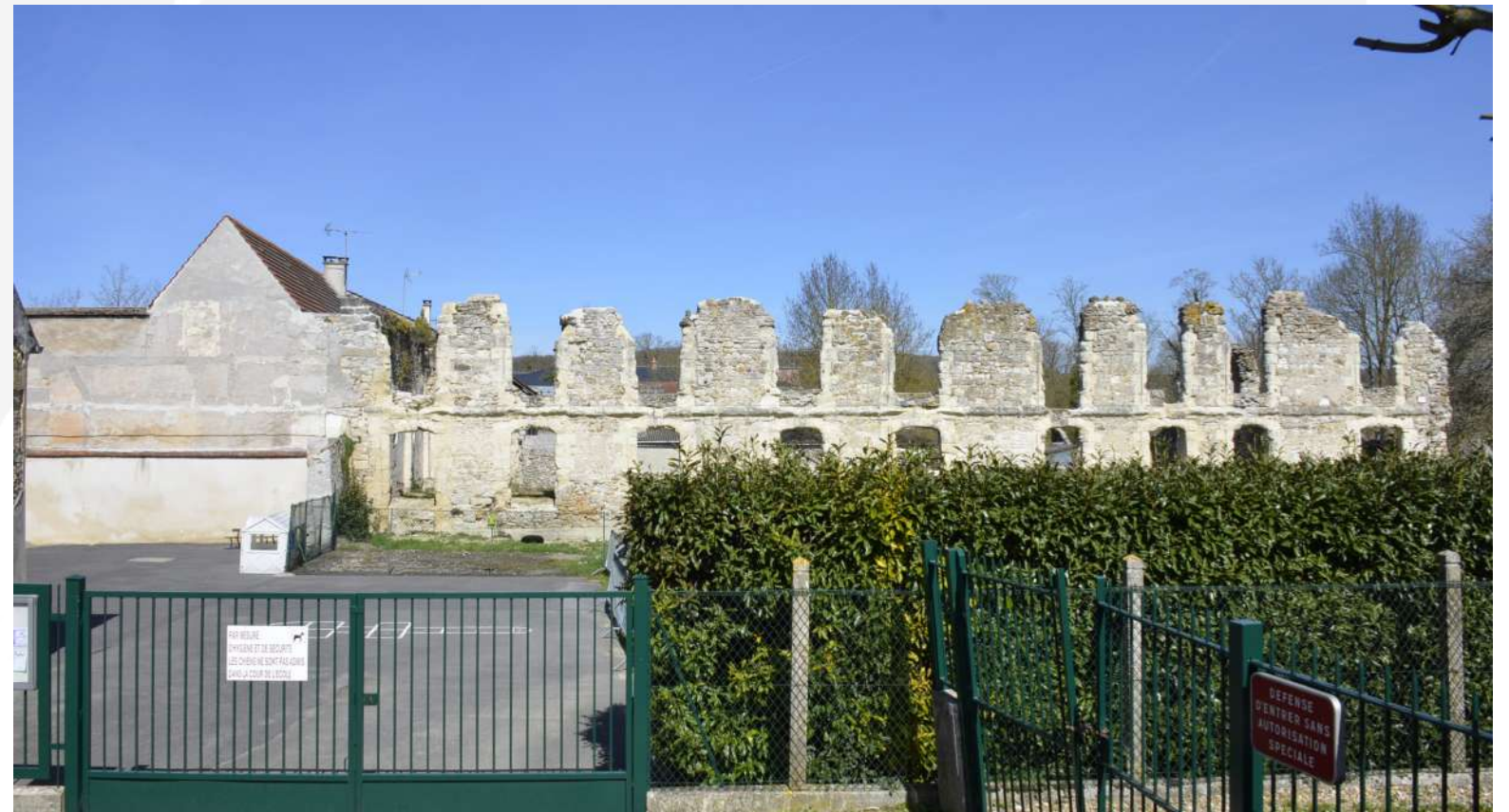
Vue sur les vestiges depuis la rue des Écoles - source : Epure paysage
